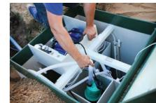
Подсоединение насоса для принудительного выброса очищенной воды.
