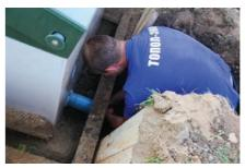
Врезка в приемную камеру непосредственно по месту подведения канализационной трубы. Подсоединение проложенных труб.
