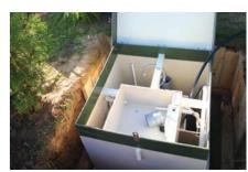
Одновременная, по 0,5 м, обсыпка песком снаружи УОСВ и заливка водой внутри. Это делается для компенсации внешнего и внутреннего давления на стенки установки.
