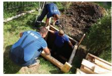
Для опалубки используется прочный брус 100х100 и доски 150х40 длиной 3-6 м, в зависимости от размера котлована. По окончанию монтажа опалубку можно либо засыпать, либо снять и оставить Заказчику.
