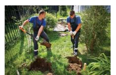
Рытье котлована вручную, без использования габаритной техники. Сохраняем нетронутым ланд-шафтный дизайн. Когда глубина котлована становится более 1 метра — по технике безопасности необходимо ставить опалубку.
